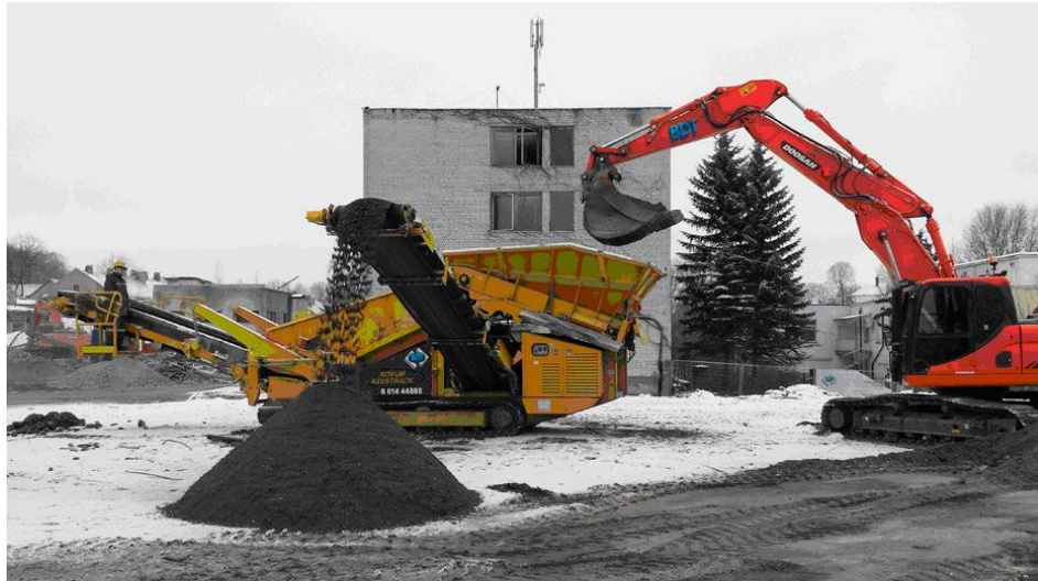
14 pav. Užteršto ir švaraus grunto maišymas
